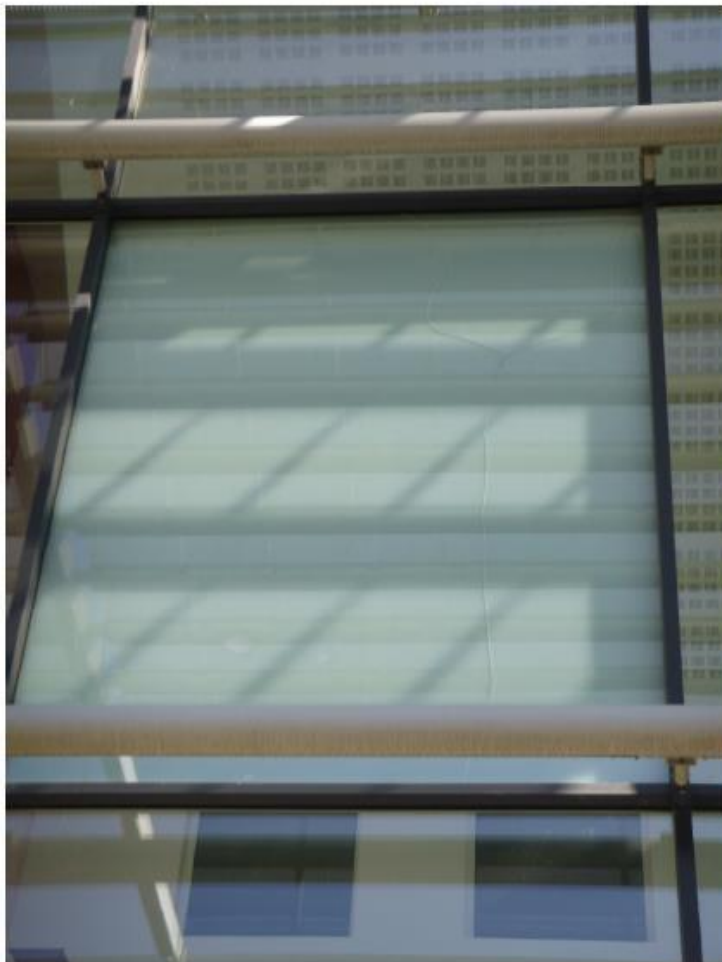
Vitrage fendue F5 – entre les files 2-21 & 2-22 au niveau 2
